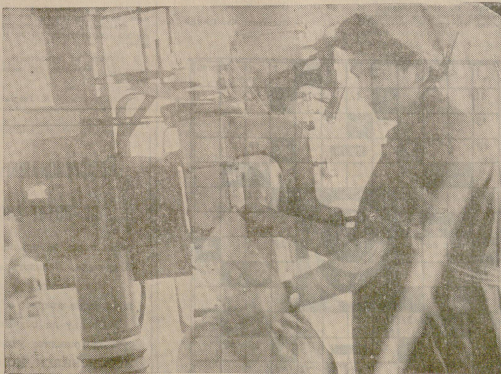
Във Фуражния завод — Горна Оряховица всички процеси са механизирани и автоматизирани. Механизирани е и заключителният етап от производството — пакетирането и зашиването на пълните книжни торби.
