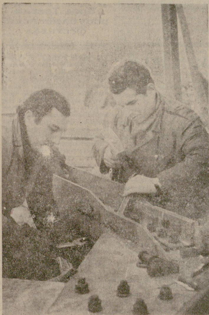
На строежа на Химкомбината в Свищов монтажниците Ангел Кузманов и Кирил Владимиров влагат изключително старание в подготовката и монтажа на новия четиридесеттонен кран. Сн.: Н. КАЧАКОВ
