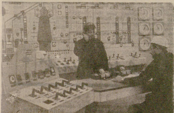
В ждановския завод „Азовсталь“ е реконструирана деменна пещ № 3.
