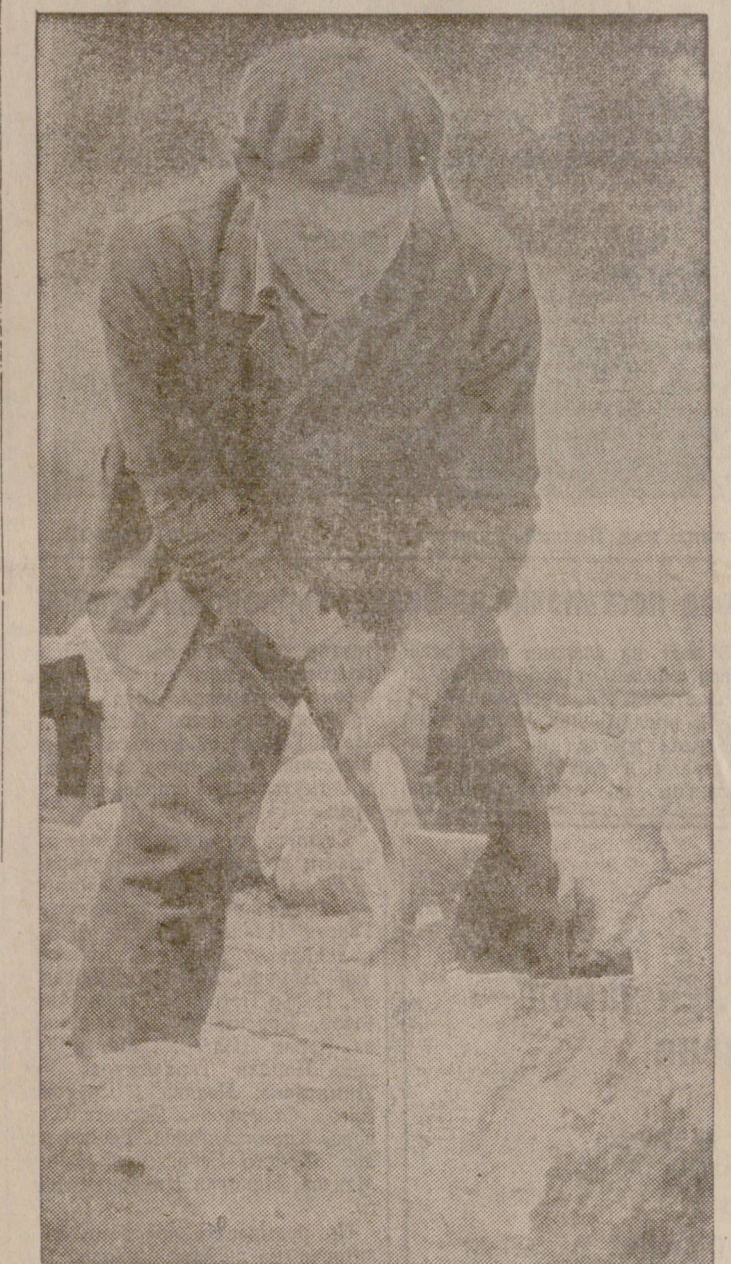
Станчо Неделчев обработва поредния камък за кейовата стена.
