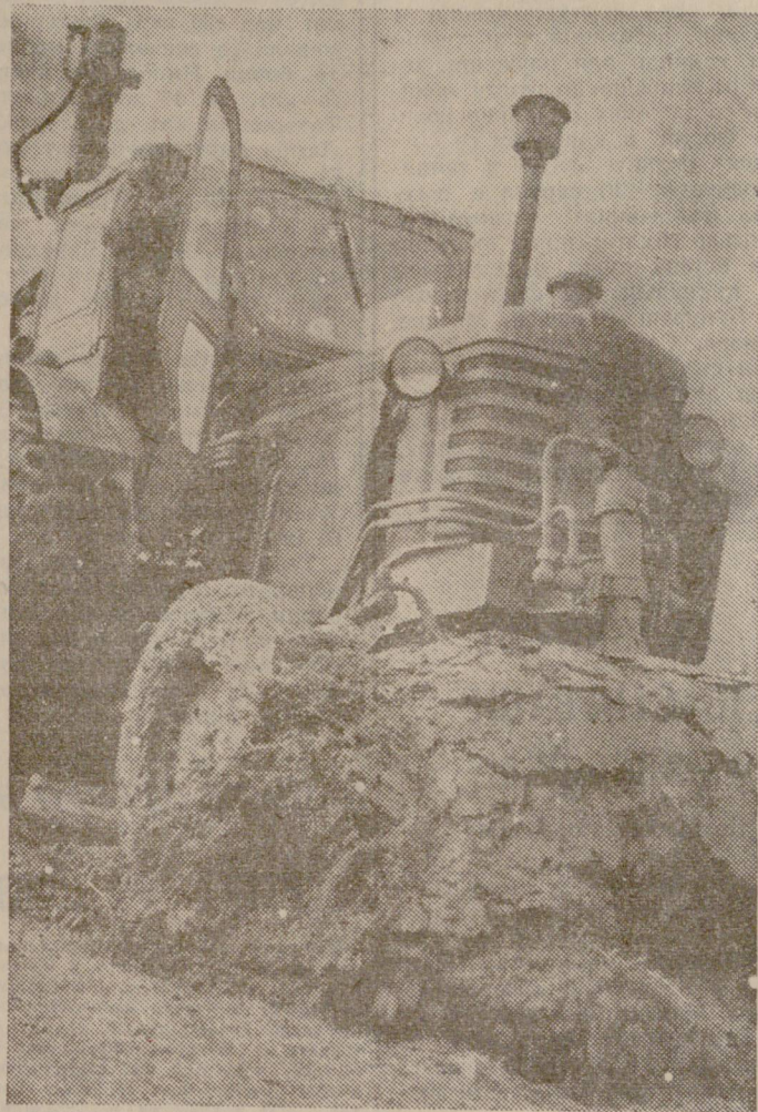
Механизаторът Димо Николов подравня строителния терен. Сп.: Н. КАЧАКОВ.
