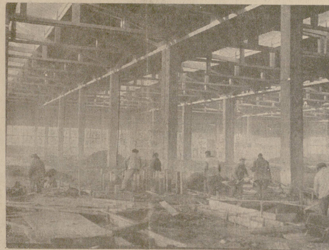
В главния корпус на завода.
