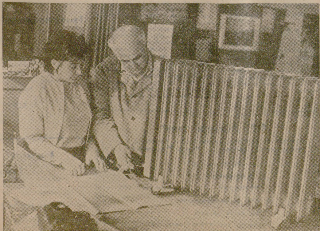
В БТР за горивна техника край Г. Оряховица. Инж. Стефка Стойчева и отличникът на Министерството на машиностроенето Иван Симеонов извършват последна проверка на едно от най-новите изделия на базата — гандерният електрически радиатор „Китен“ с мощност 2500 вата.
