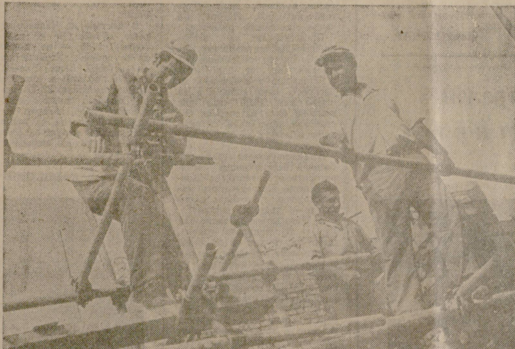
В помощ на строителите на Химкомбината край Свищов са и най-добрите бригади от Строителния район в града. На снимката: част от бригадата на Борис Великов, която монтира тръбното скеле за подстанцията към Щапелния завод.
