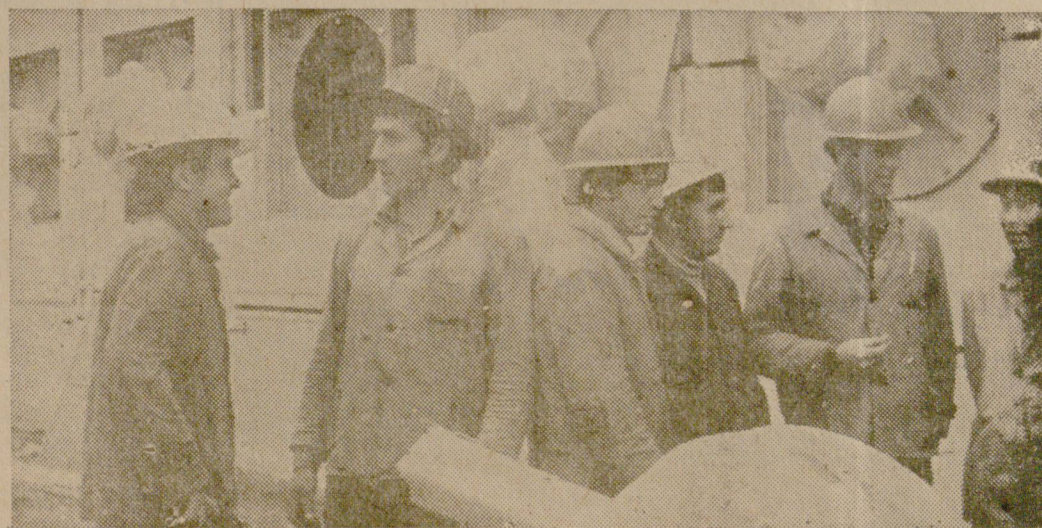
На обект „Сушене на позидно влакно“ към Химическия комбинат край Свищов сложната японска техника се монтира от комсомолската бригада на Никола Тодоров. Създадената отлична организация ще позволи с 25—30 дни преди срока да се монтират машините.
