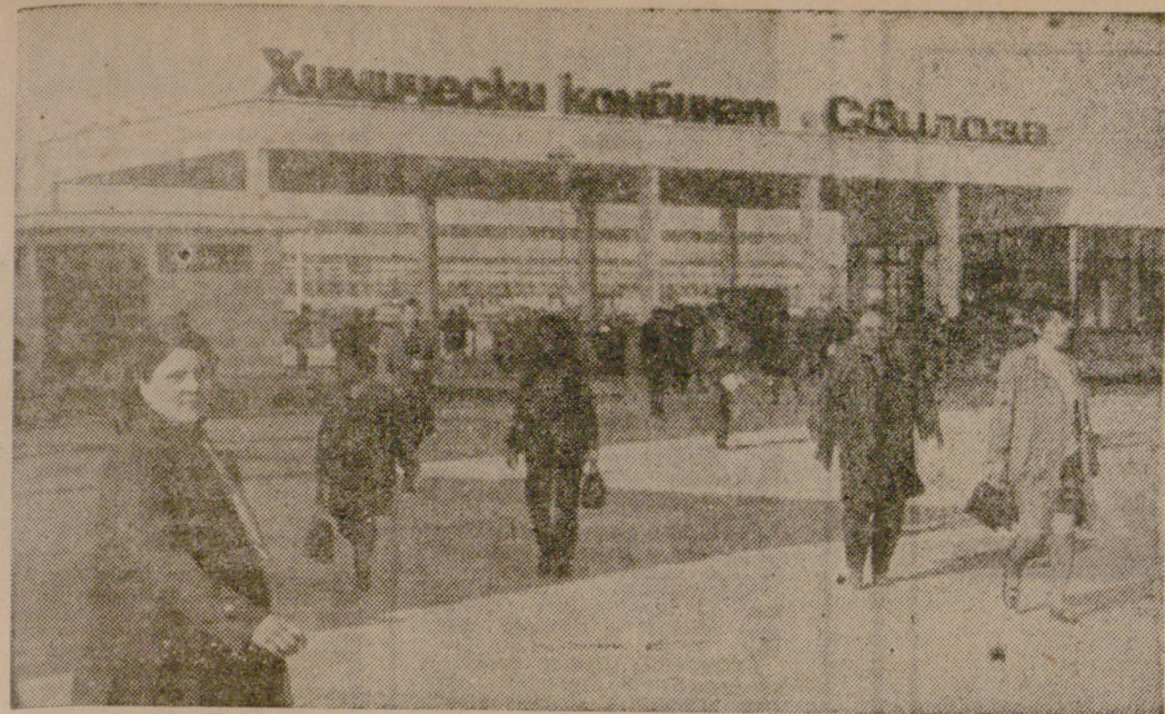
Завършил е работният ден на монтажници, строители и специалисти от Химическия комбинат... А сега, към превозните средства... Всеки в своя дом.
