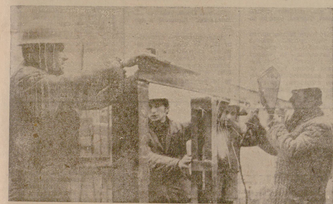
Монтажната бригада на Петър Крумов по време на работа в отделението за облагородителни разтвори.
