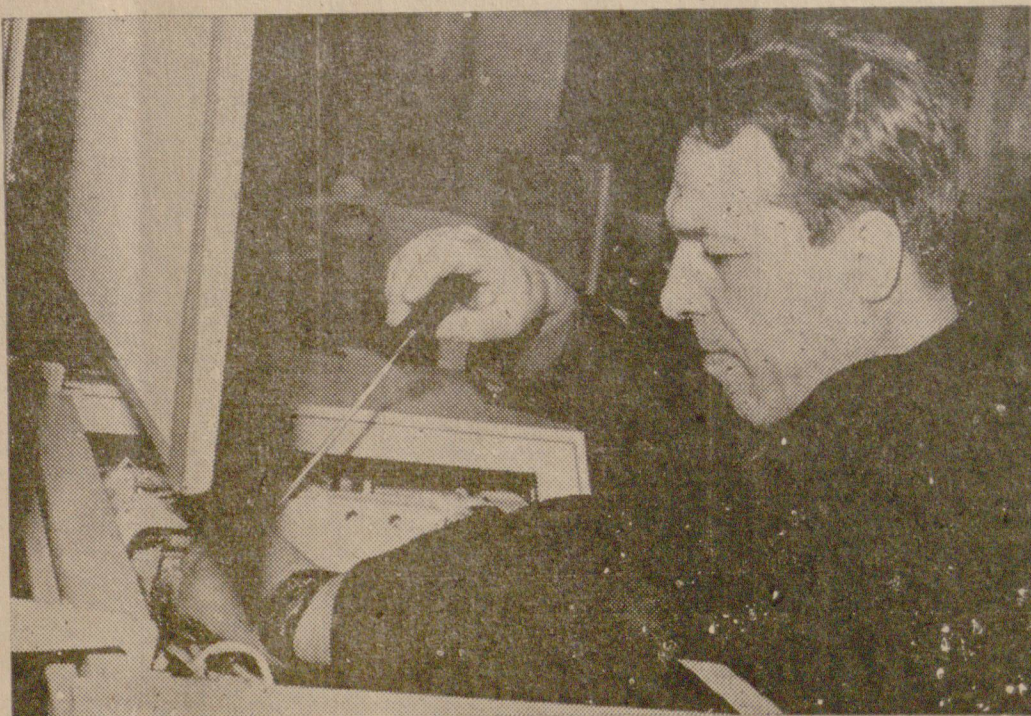
Неоценима е помощта на съветските специалисти при монтажа на електронно-изчислителната машина Минск-32 в Териториалния изчислителен център — Велико Търново. На снимката: Виталий Михайлович Ряснянский работи върху настройката на устройството за широк лент.
