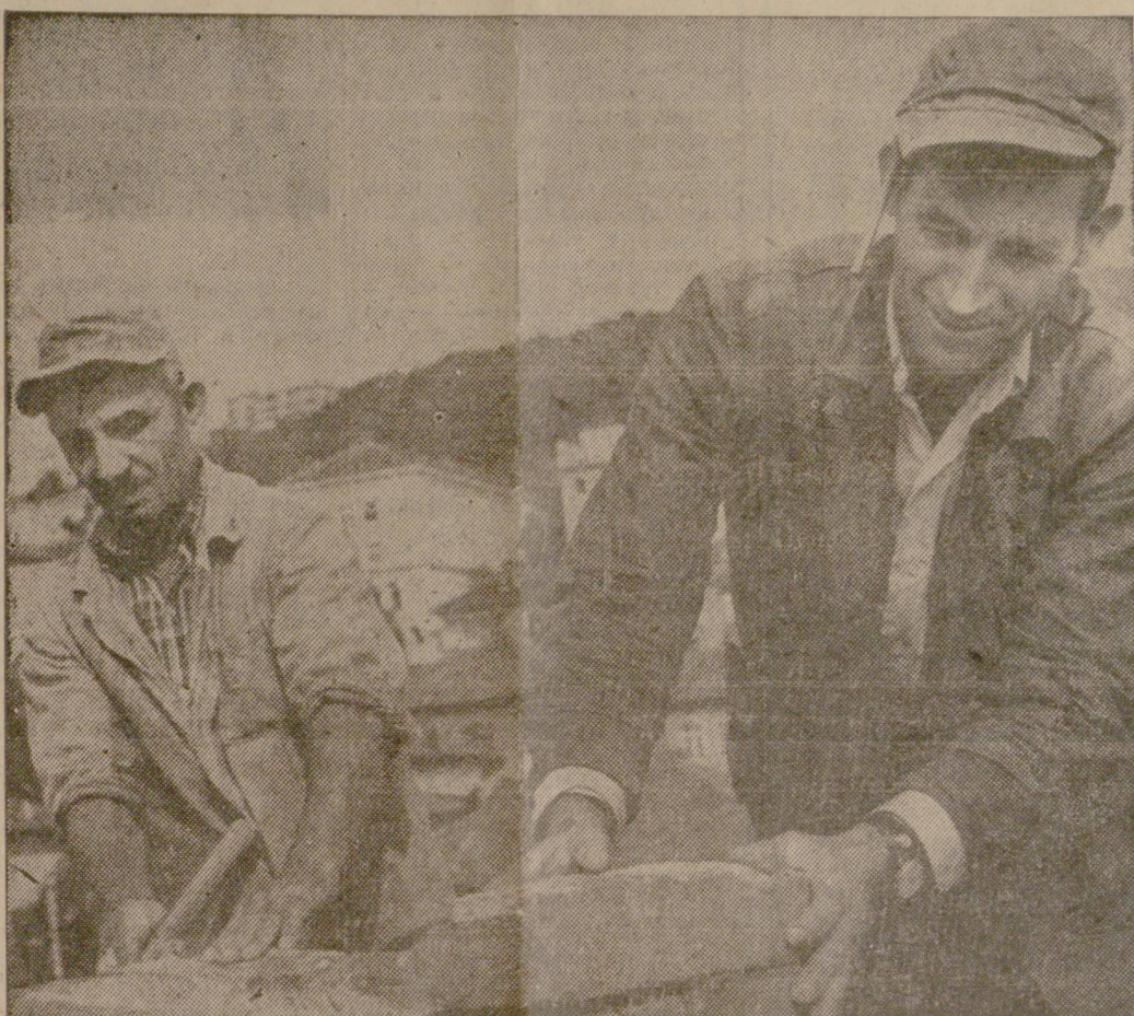
На строежа на новия хотел-ресторант във Велико Търново майсторите-строители Стефан Милков и Иордан Апостолов работят с ускорени темпове по покривната конструкция на блок — 2.
