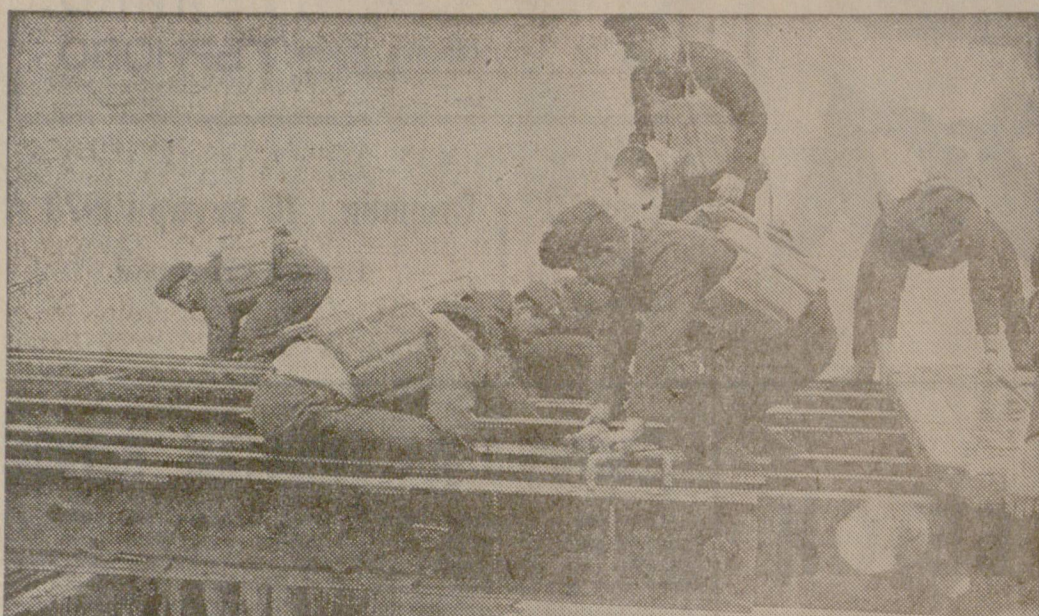
При построяването на понтонен мост всички понтони от поделението на офицера Танев извършва строго определена дейност. Нали така се съхраняват нормите по неговото горно Снимка: Т. КАПИТАНОВ
