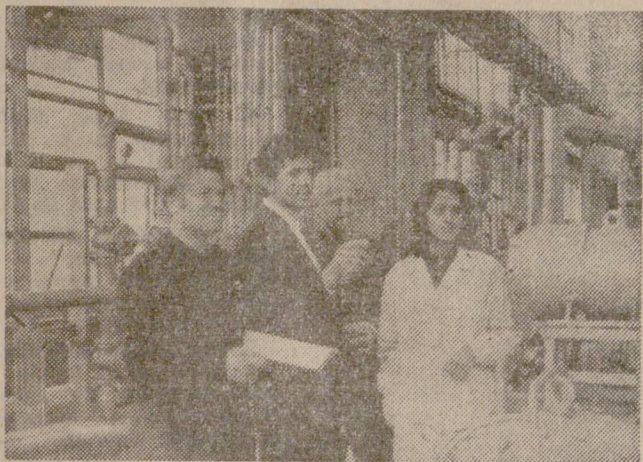
Влезе в строя инсталацията за въздухоразделяне към химическия комбинат за минерални торове — Деяна. Тя е съоръжена със съветска техника и техника от СССР.
