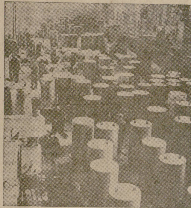
Производствена линия в завод за електротермично оборудване се отличава с високо качество. НА СНИМКАТА: монтажният цех на електроводонагревателите за нуждите на селското стопанство
