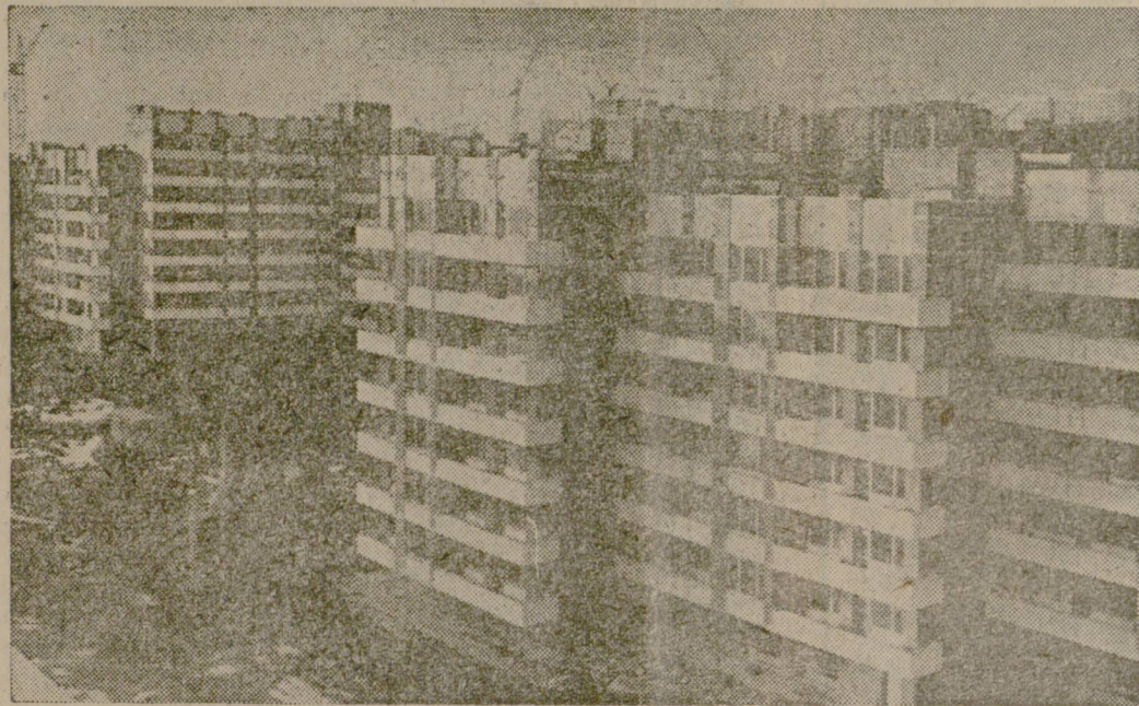
Само за няколко години строителите издигнаха тези жилищни блокове в кв. „Тригълника“, на мястото на малки овощни и зеленчукови градини и пустеещи земи.
