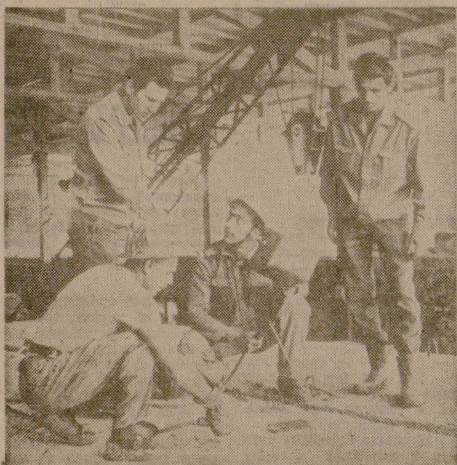
Бойците-монтажници Никола Василев и Михаил Иванов под ръководството на офицерите в момент на работа.
