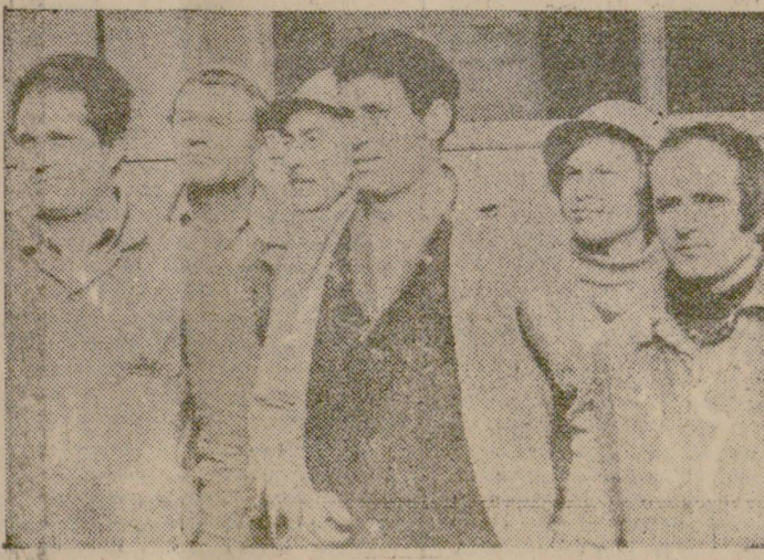
Зидарокофражистите от бригадата на Костадин Караджов (в средата) са между първите, които започнаха изграждането на завода. Те изпълняват висококачествено зидарокофражистите работи.
