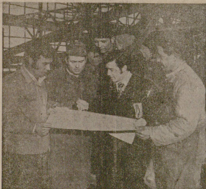
Благодарение на постоянната помощ на технологичния отдел при Завода за метални конструкции — Стражица, с началник Калчо Калев, бригадата на Райчо Иванов успешно усвоява новите производства.
