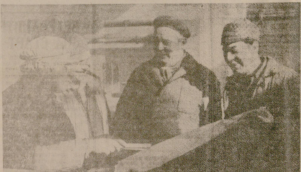
В монтажа на машините и съоръженията в Завода за тютюн и кестно брашно в Крушово участват и работници от бригадата на Иван Делинчиков. Темповете на работата показват, че те ще изпълнят обещанието за предсрочно и качествено монтиране на поверените им машини.
